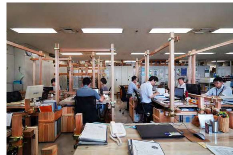
ワークスペースをつなぐ 徳島県庁スマート林業課「オフィスの木質化トライアル」 ワークスペースのインテリアとして、職員のみなさんがつな木を組み立てました。つな木をレイアウトに応じて組み換えて、迅速なコロナ対策が実施できました。
